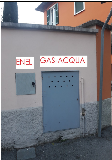
foto 5 – vani contatore ENEL, Gas, Acqua
